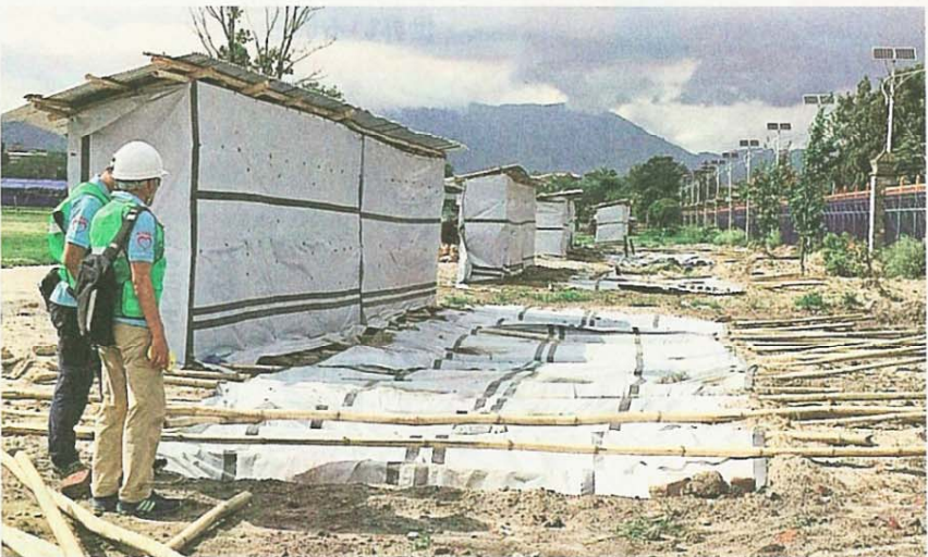
左側に見える小屋がトイレ。排水は白いシートの下に掘られた穴にためられている
