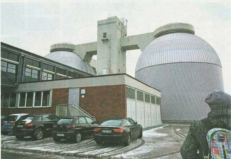
ドイツ・ニュルンベルク郊外の下水処理場のメタン発酵槽
